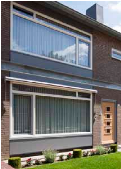
Renovatie van jaren '70 woning
